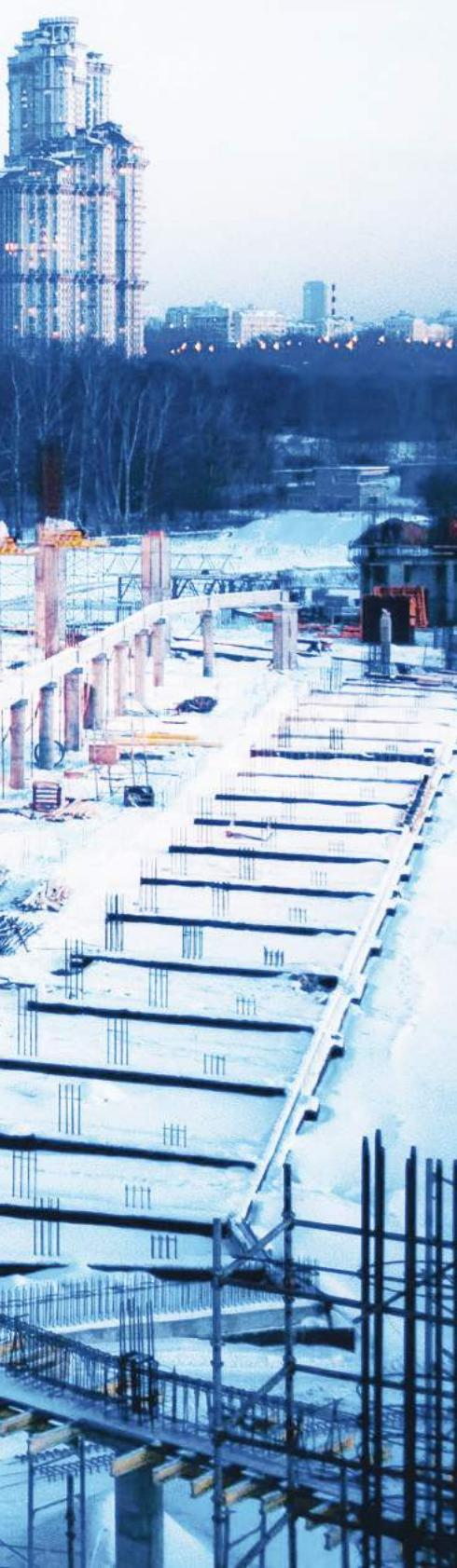
Оптимальной температурой среды для твердения бетона условно считается +15...+20°C. Скорость процесса гидратации цементной смеси сильно замедляется в случае снижения температуры и практически приостанавливается при +5°C. При температуре ниже 0°C в бетоне прекращаются процессы гидратации, т.е. взаимодействие минералов цемента с водой. Твердение бетона приостанавливается, так как бетон замерзает, превращаясь в монолит, прочность которого обусловливается силами смерзания.
